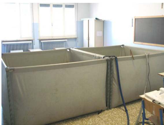
Prova di carico su solaio per la determinazione della capacità portante
