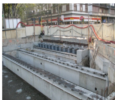
Monitoraggio in continuo di un ponte tranviario
