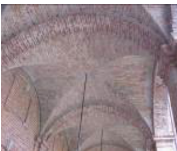
Volte a crociera durante una prova di carico impulsivo
