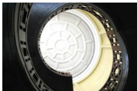
Prova dinamica e di carico su scala elicoidale per la sua verifica della capacità portante
