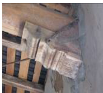
Appoggio di solaio in legno
